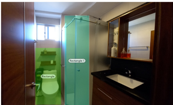
Figura 9: Infraestructura interna del baño Fuente: Empresa AMC Realizado por: Vallejo, L.; Pilco, W. & Chicaiza, S. (2021)
